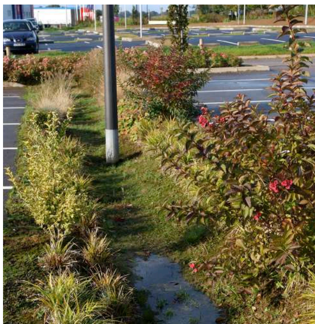
Exemple d'une noue paysagère
