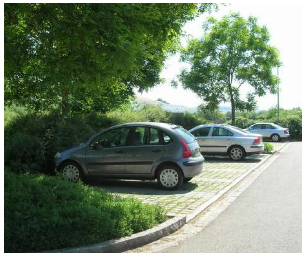
Exemple de places de stationnement en dalle engazonnée
